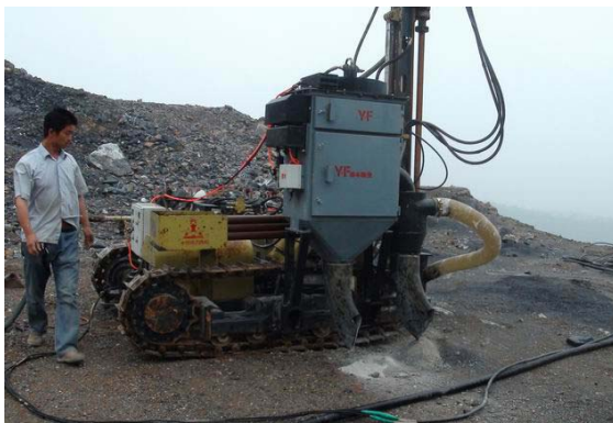
钻孔现场及设备除尘器
