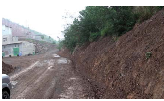
运输道路两侧排水沟
