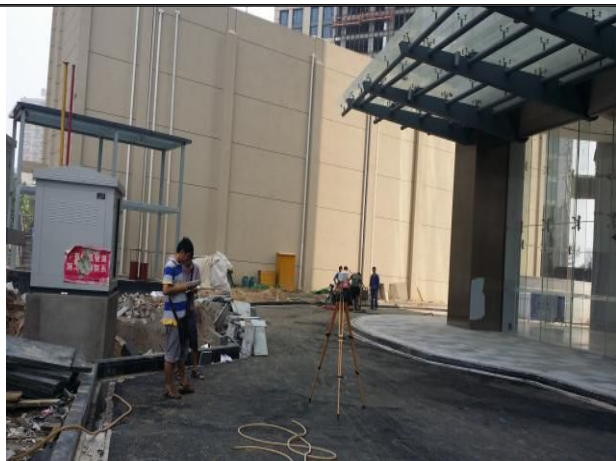
变电站东南侧 3m 华润大厦
