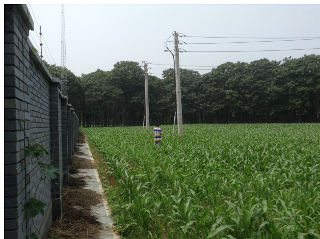
变电站西北侧现状（农田）
