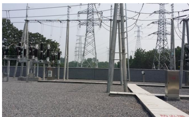
站内敷设碎石子固化
