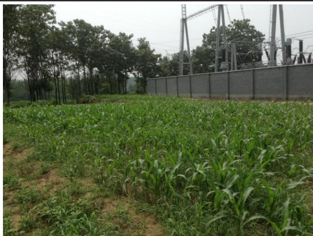
变电站东北侧 110kV 出线侧
