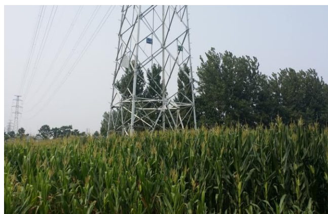
线路塔基植被恢复
