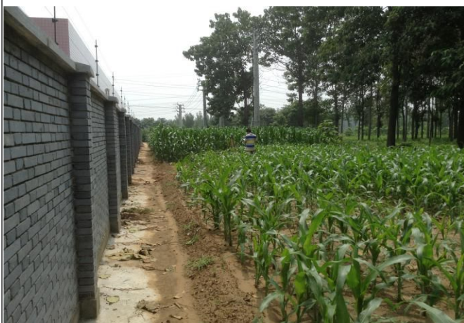
变电站四周监测照片
