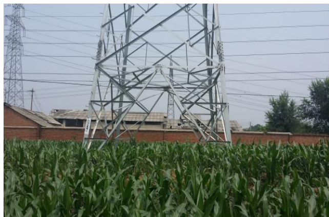
线路塔基植被恢复
