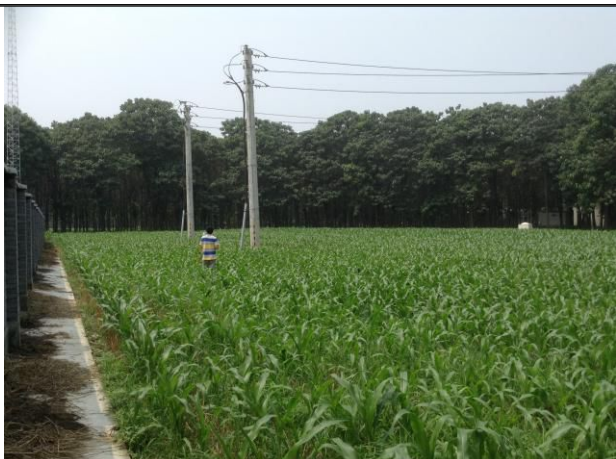
变电站西侧现状
