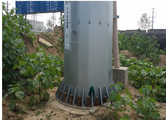
果岭（姜寨）葵香接入点塔基现状
