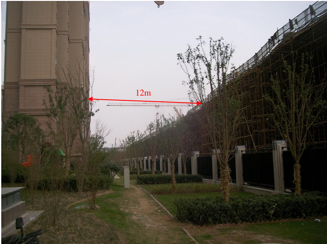
绿地 新里卢浮公馆小区最近居民楼与陇海路高架（建设中）相对位置关系
