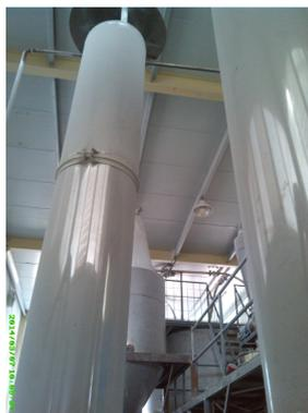
图 3-5 磨粉尾气排气筒
