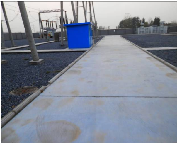
站内地面道路硬化情况
