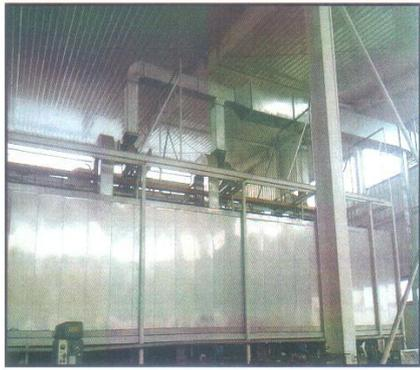
烘干废气经燃烧机处理后 15m 高排放
