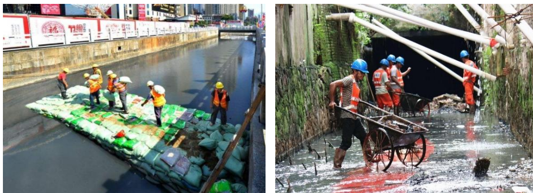
图 3.3-3 围堰施工、人工清淤
